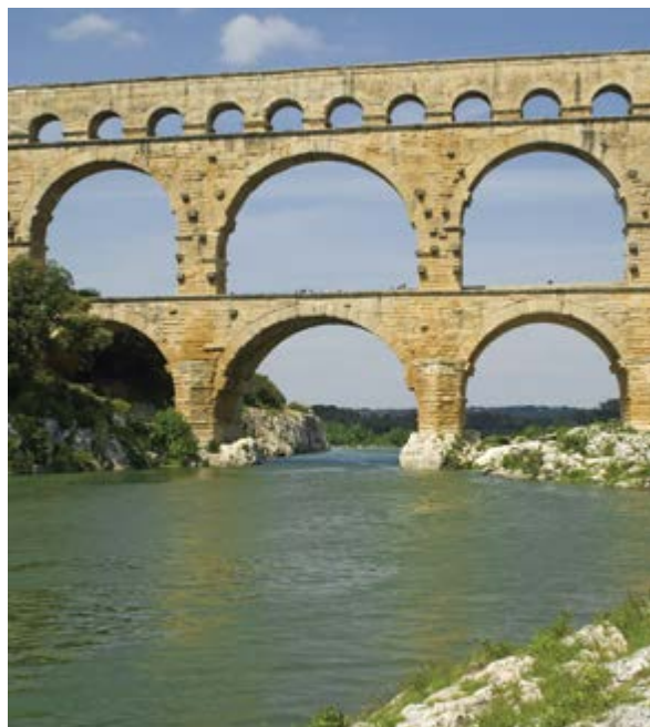
Ejemplo de un acueducto romano como se ve en la actualidad
